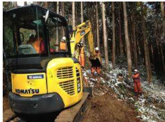
石巻市での作業道実習（12月）
